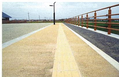
道の駅 那賀川 通路舗装 (徳島県)
