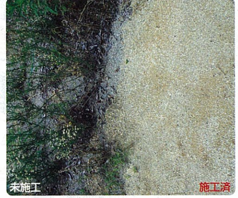
施工後 約5年経過 まだ効果は続いています。
