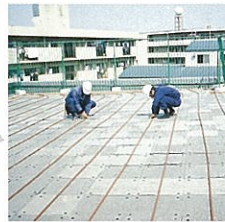
④灌水装置の設置
