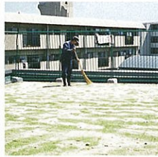
⑦目土の散布
